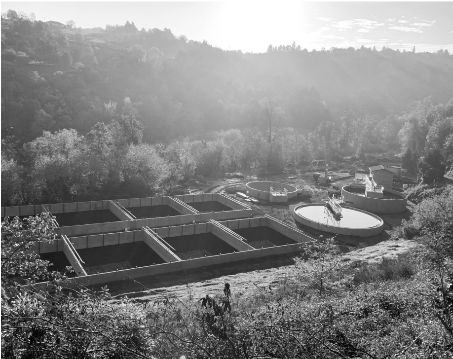
Photo de l’ouvrage octobre 2019
