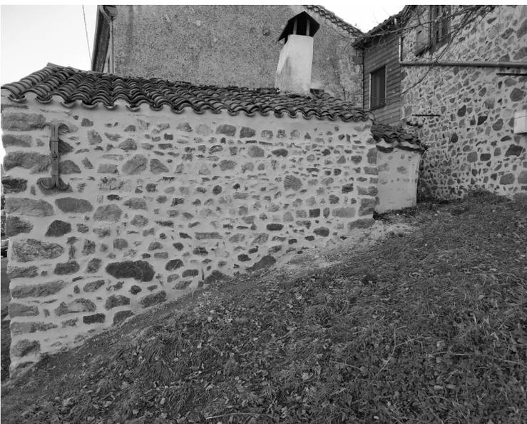
Des premiers travaux ont déjà été faits avec notamment le changement de la porte du four de Brugerolles et le rejointement des pierres des murs du four du Monteil (travaux réalisés par un artisan de la commune, Romain CHOLLET).
