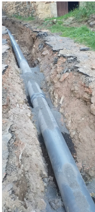
Reprise des réseaux d'assainissement au village de Champlong
